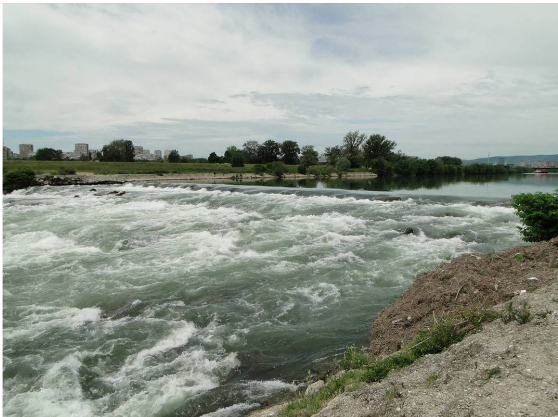
Slika 1.4.3: Prag TE-TO Zagreb (lipanj 2014.)
